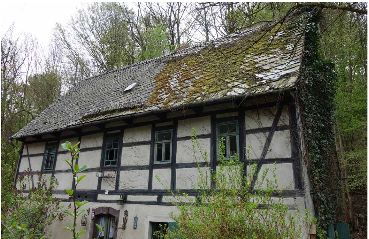
Abb. 9 | Historisches Gebäude in Leisnig, Scheergrund 2, erbaut 1826. Die Dachhaut in altdeutscher Deckung besteht aus regionalem Dachschiefer (Zustand 2022).
