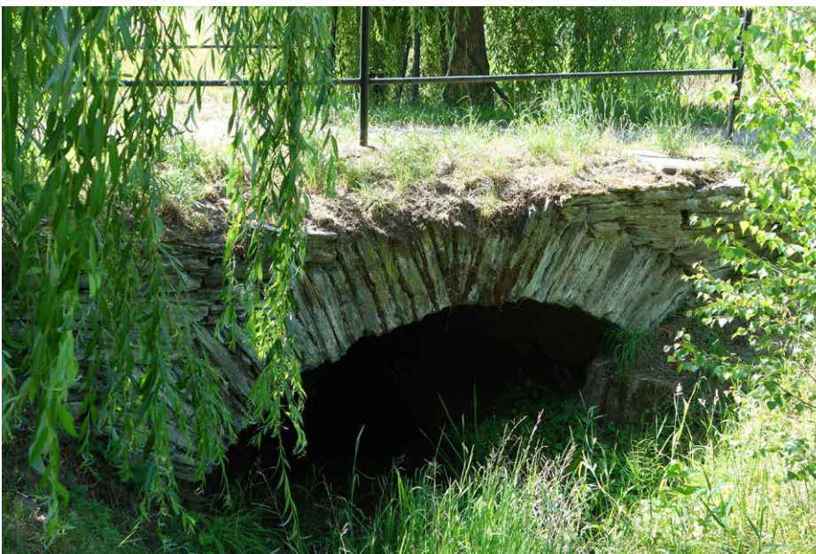
Abb. 19 | Brücke aus Schieferplatten über den Leitebach im Ort Penna.
