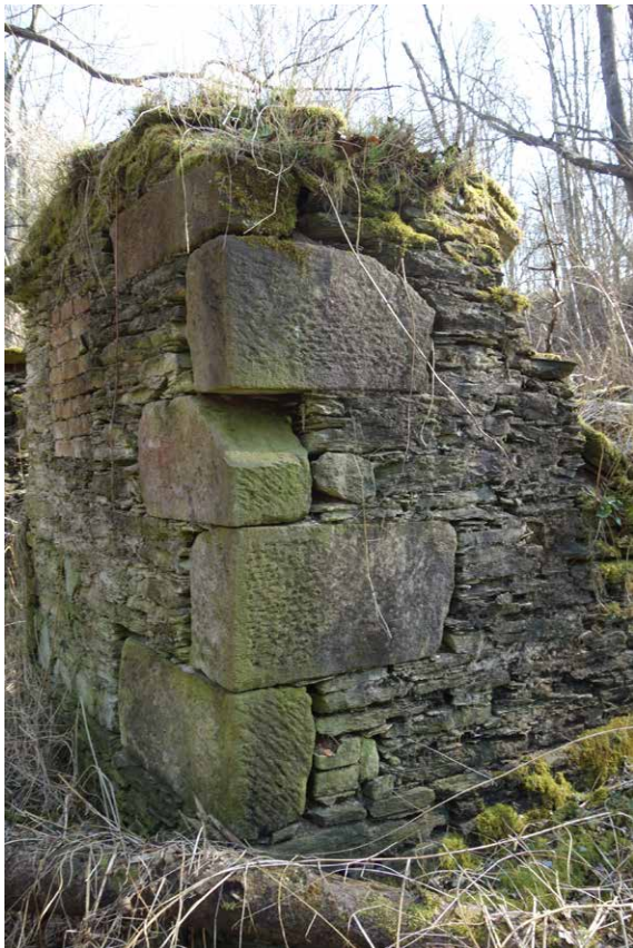
Abb. 17 | Ruine der Lochmühle südlich von Rux (Zustand 2022). Das Mauerwerk besteht aus Schieferplatten, Werksteine für Eckquaderung und Gewände aus Rochlitzer Porphyrtuff.
