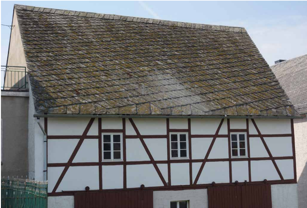
Abb. 20 | Erhaltenes Beispiel für die altdeutsche Deckung mit lokalem Dachschiefer (Lastau, Dorfstr. 13; Zustand 2022).
