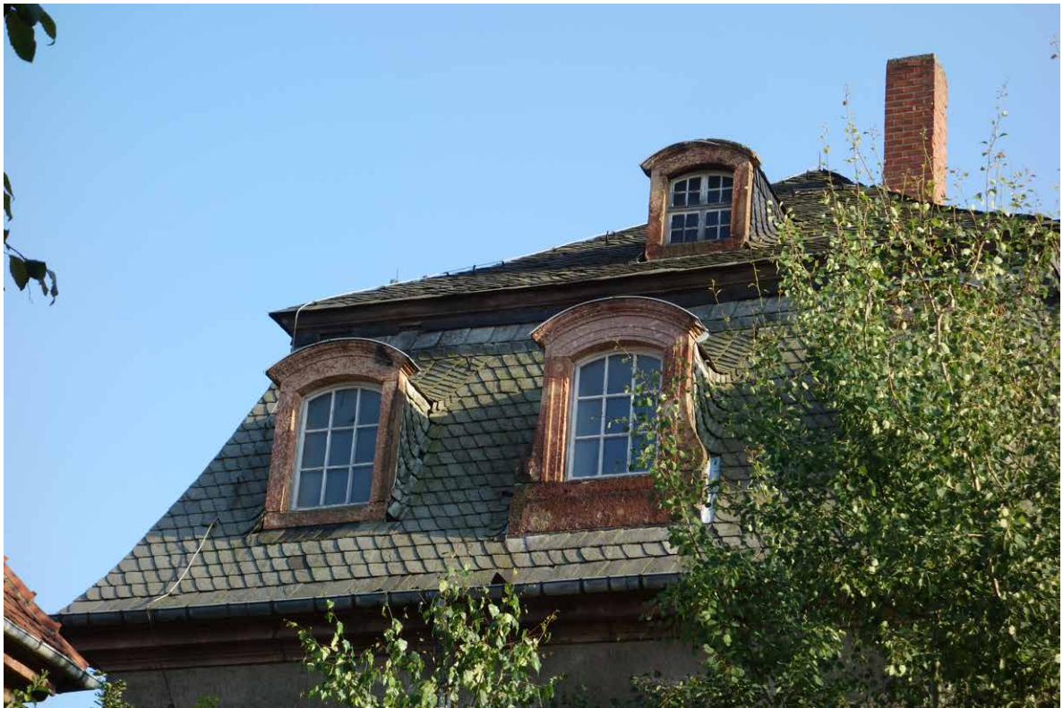
Abb. 24 | Erhaltene historische Dachdeckung des Schlößchens Neusorge, nach Heusinger (1936) eine der letzten Verwendungen von Methauer Schiefer (Zustand 2022).
