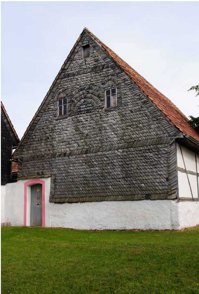
Abb. 26 | Giebelgestaltung an einem Gebäude des Vorseithofs in Aitzendorf, Obere Dorfstr. 24 an der Bundesstraße B 175 mit lokalem Dachschiefer (Zustand 2022).
