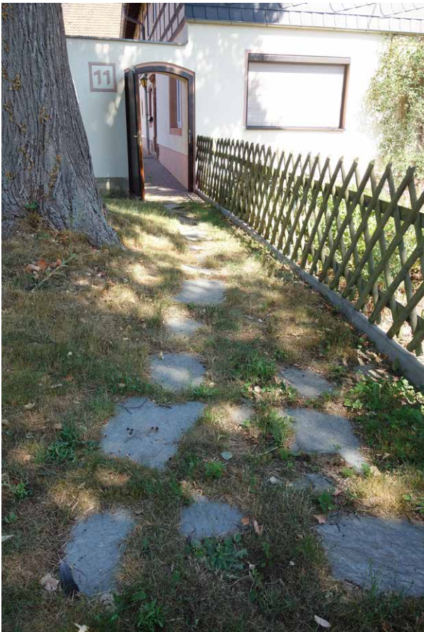
Abb. 15 Rechtwinklig formatierte Fußbodenplatten aus paläozoischem Schiefer mit einheitlichen Kantenmaßen (1 Sächsische Elle, ca. 56,6 cm). Die Platten stammen wohl aus älteren Verlegungen und wurden in den 1960er Jahren für die Fußbodengestaltung bei Umbauten in Schloss Rochlitz (hier Durchgang ehemaliger Torturm) genutzt (frdl. Mitt. S. Reuther, LfD Sachsen).
