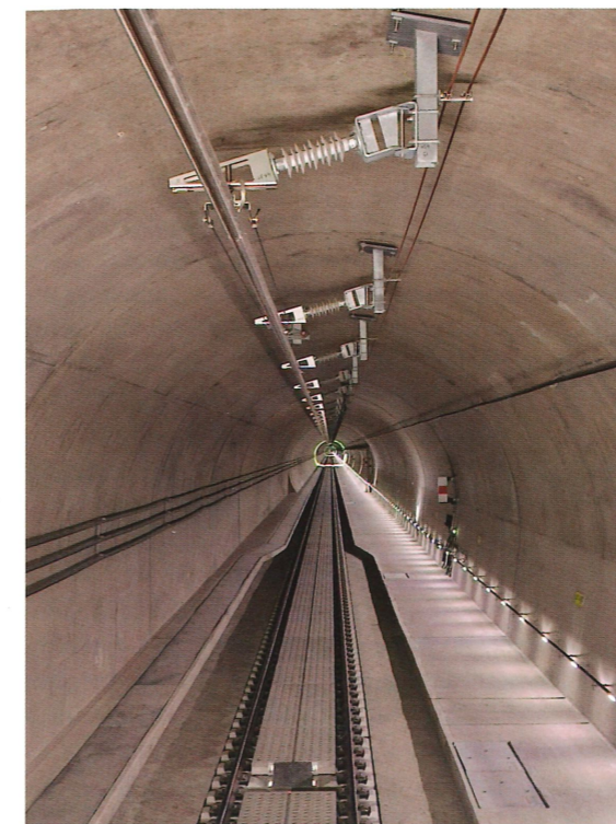
Bild 4: Koralmtunnel mit Oberleitungsstromschiensystem (Foto: F. Eckardt).
