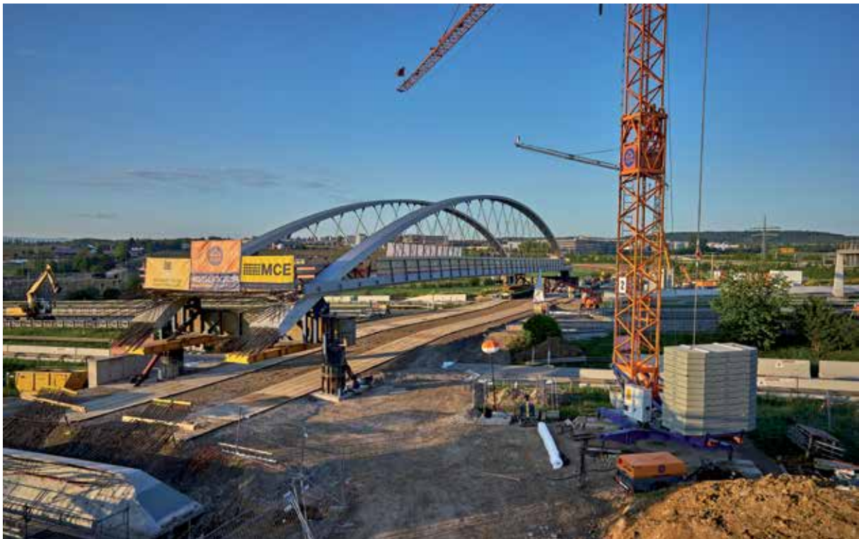
Bild 18 Bogensegment in seiner Endlage auf den temporären Gerüsttürmen © Octonauten
