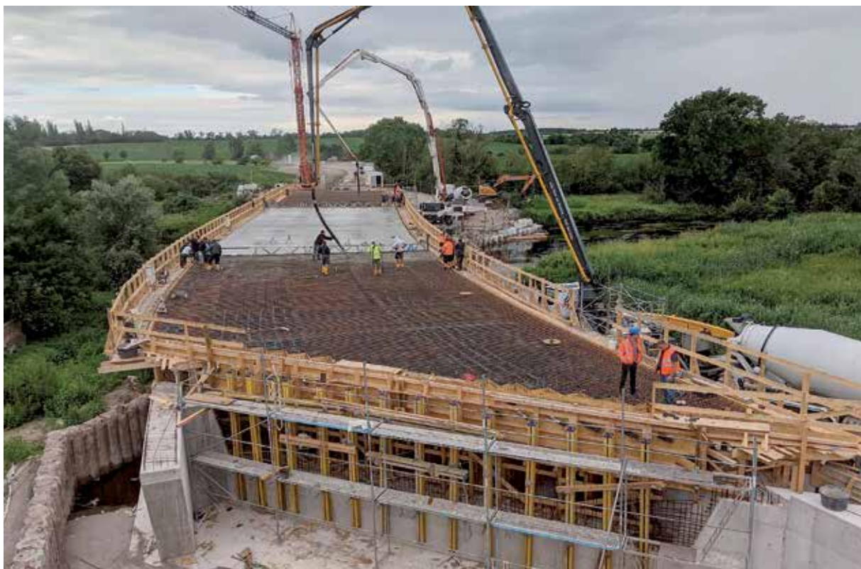
Betonage des Überbaus der Brücke über die Bode bei Neugattersleben
