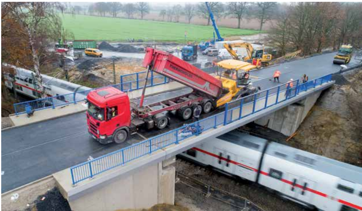
Aufbringen der Asphaltschicht
