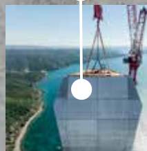
Verkleidung Brückenpfeiler der Bosphorusbrücke
