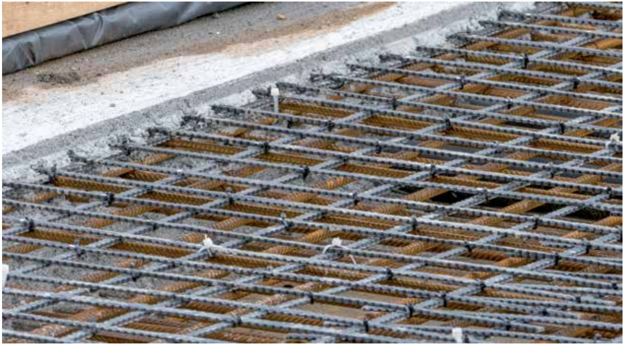
Bild 13 Verlegte Basaltbewehrung – Basalt T4
