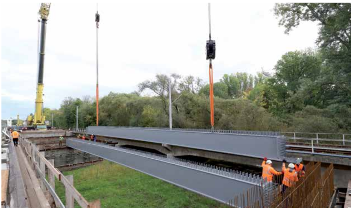
Einheben der verschweißten Hohlkästen
