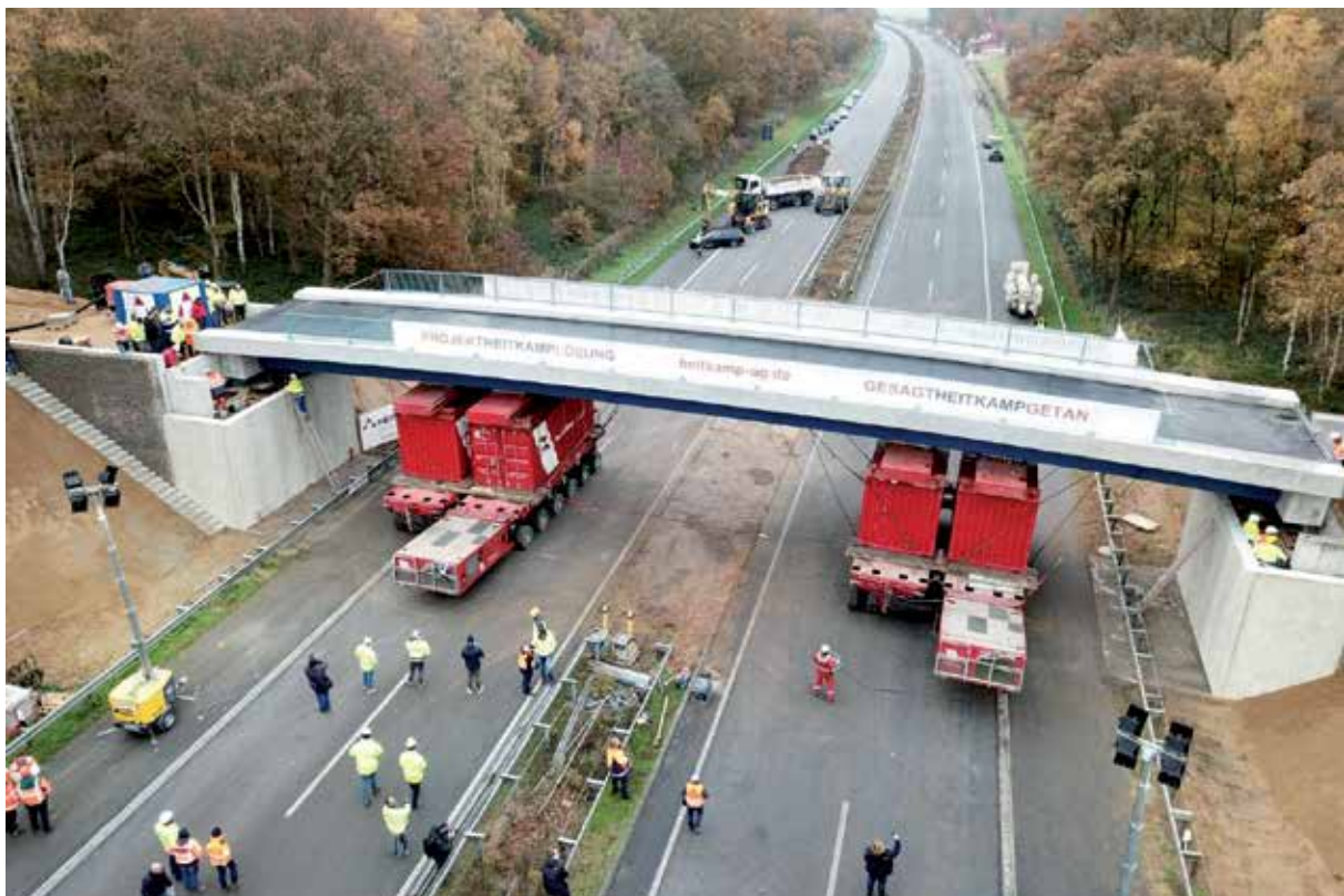
Einheben des Überbaus der Brücke Stokkumer Straße
