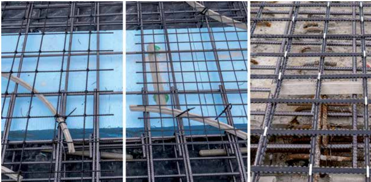
Bild 2 Eingebaute Bewehrung, von links nach rechts: solidian REMAT-CCE-Ø4-10/10 – 100 × 100 mm; solidian GRID Q71/71-CCE-51 – 71 × 71 mm; Basalt T4 – 66 × 100 mm Fotos: Harald Michler
