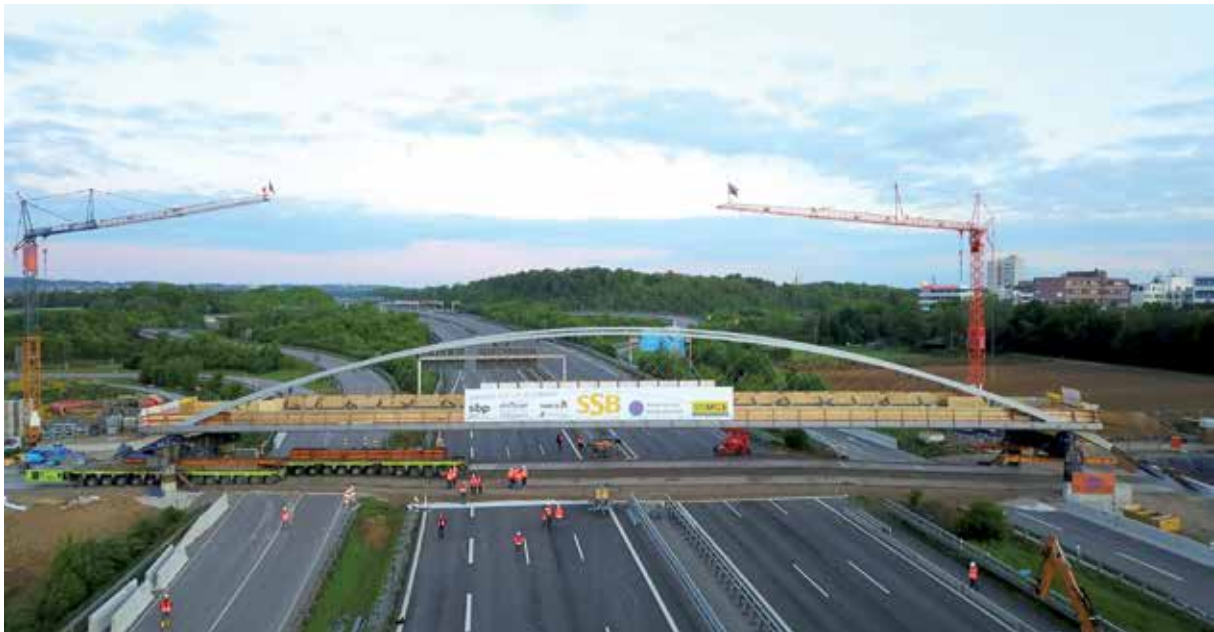
Bild 20 Bogenfeld nach erfolgreichem Einschub über die gesperrte Autobahn
