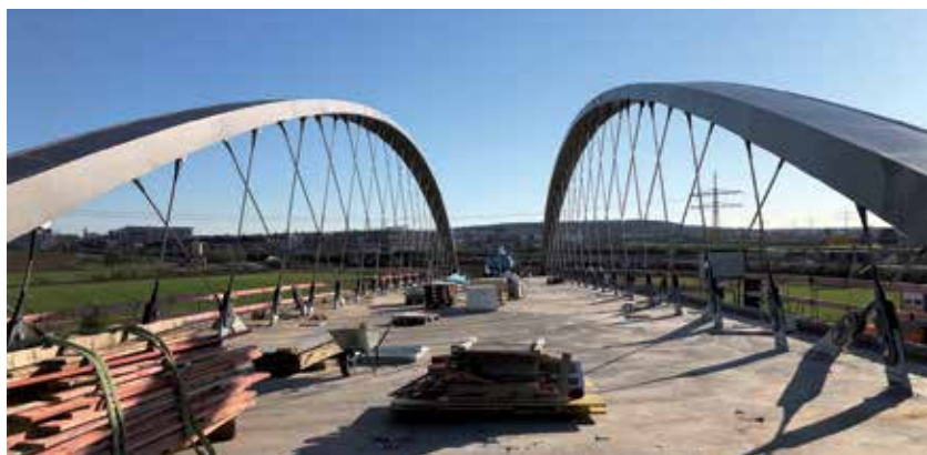
Bild 8 Bogenfeld im Bauzustand nach der Hängermontage
