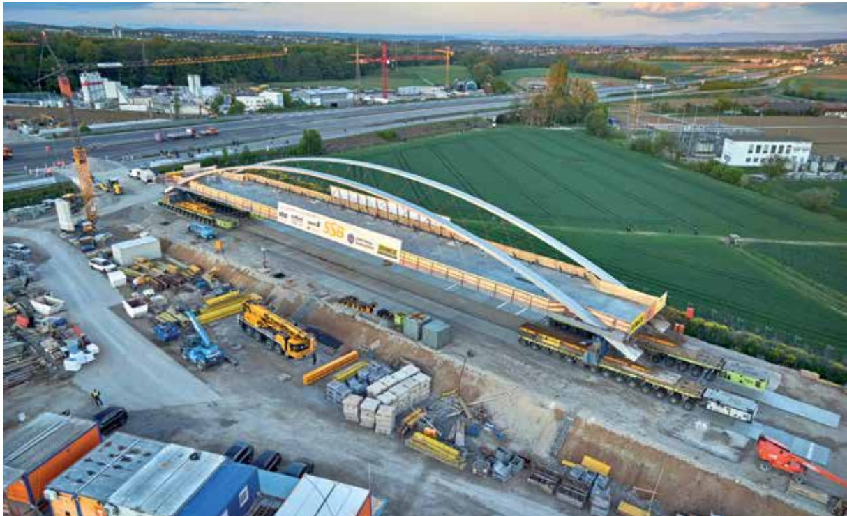
Bild 17 Fahrvorgang des Bogensegmentes über die Autobahn durch Schwerlastmodultransporter (SPMT – Self-Propelled Modular Transporter) © Octonauten
