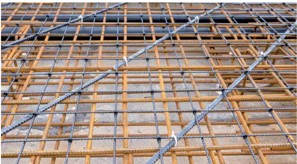
Bild 14 Verlegte Carbonbewehrung – solidian REMAT
