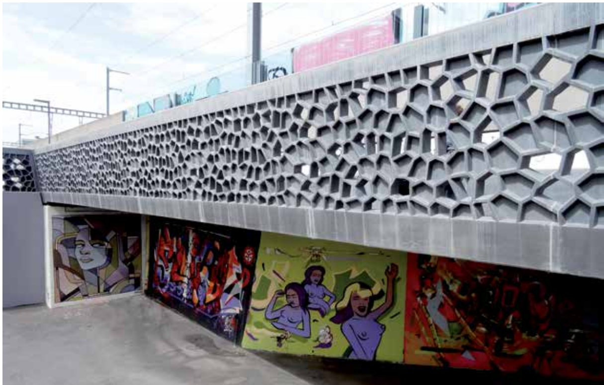
Bild 2 Stahl-UHFB-Fußgängerbrücke „Martinet“ in Lausanne (2015) mit feingliedrigem „organischem“ Steg, der die Fertigungsmöglichkeiten von UHFB demonstriert Foto: E. Brühwiler
