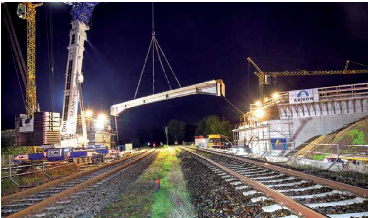
Einheben eines Verbund-Fertigteil-Trägers (VFT)
