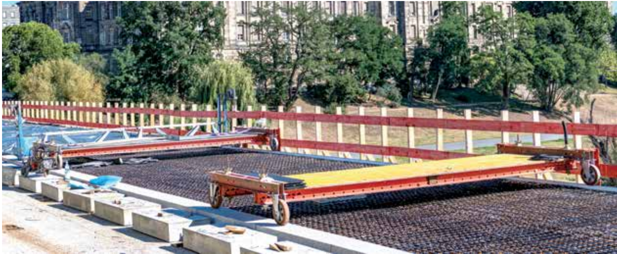
Bild 15 Betonierplattformen und Rüttelbohle
