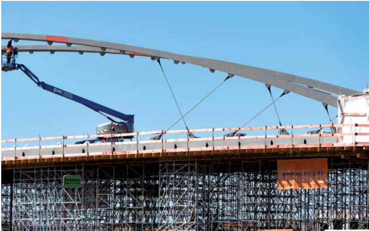
Bild 16 Montage der Hängerseile aus Carbon
