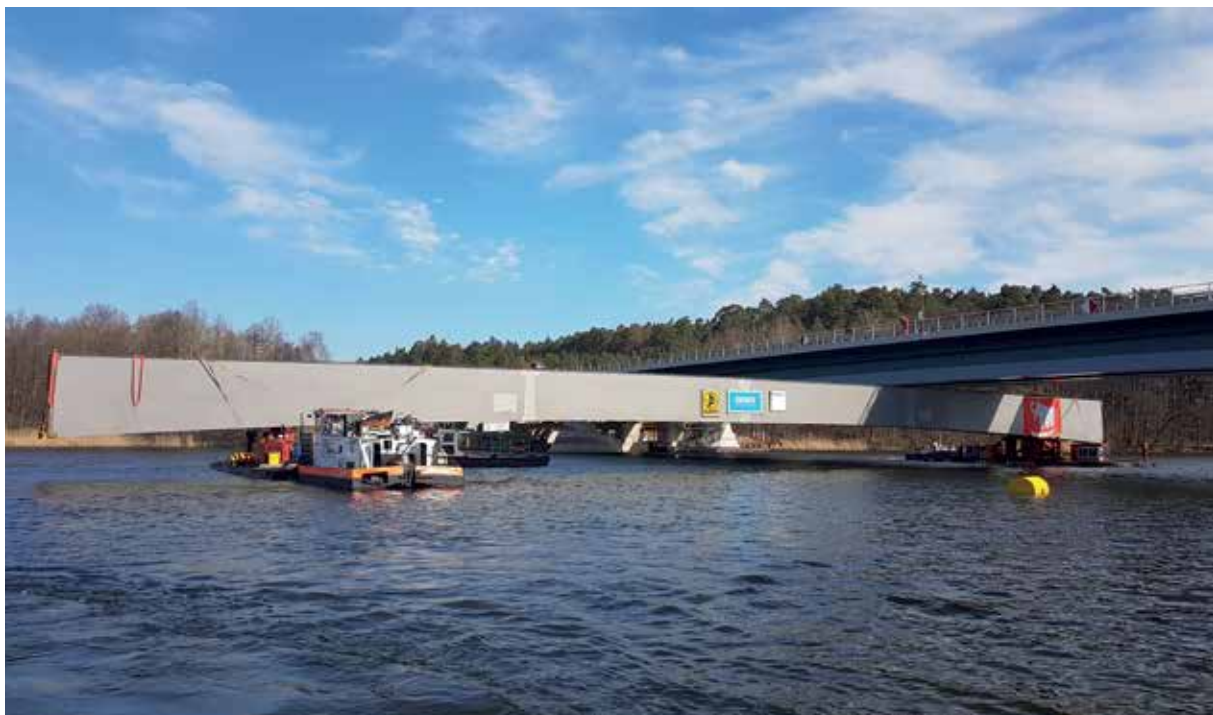
Einschwimmen eines Mittelträgers
