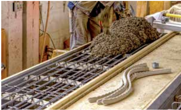
Bild 5 Herstellung der Balken, hier B03 Foto: Harald Michler
