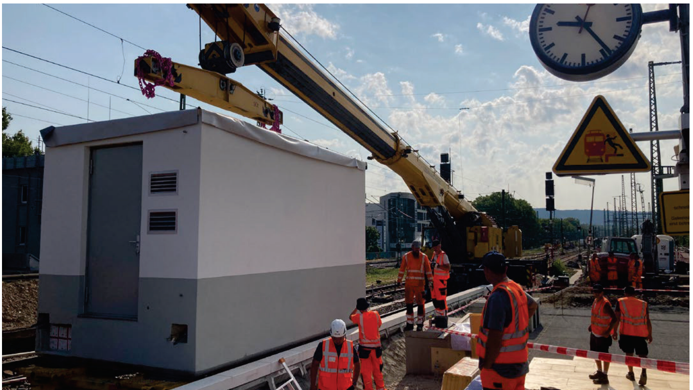
Abb. 6: Modulgebäude eines Gleisfeldkonzentrators
