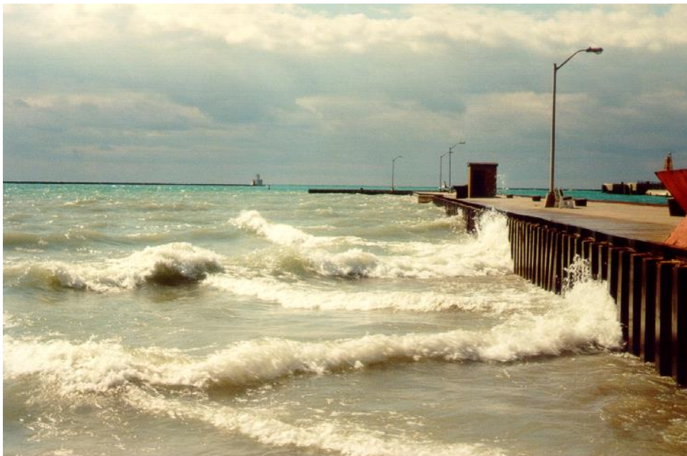
Foto 2.1-1 Reflexion von Wellen an einer Mole – (Lake Huron / Ontario; privat)
