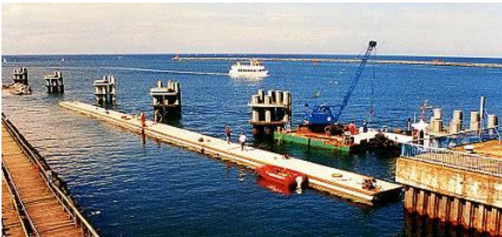
Foto 3.1-1 Schwimmender Wellenbrecher, Warnemünde/Ostsee (CLEMENT)
