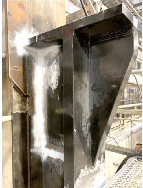
Bild 11: Regelkonsole nach Fertigstellung von Schweißarbeiten und ZFP
