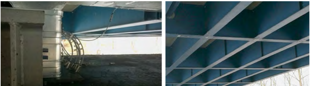
Bild 8: Messzentrale, eingerichtet auf der Widerlagerbank (links), Lage der Dehnmessstreifen im Messquerschnitt (rechts)
