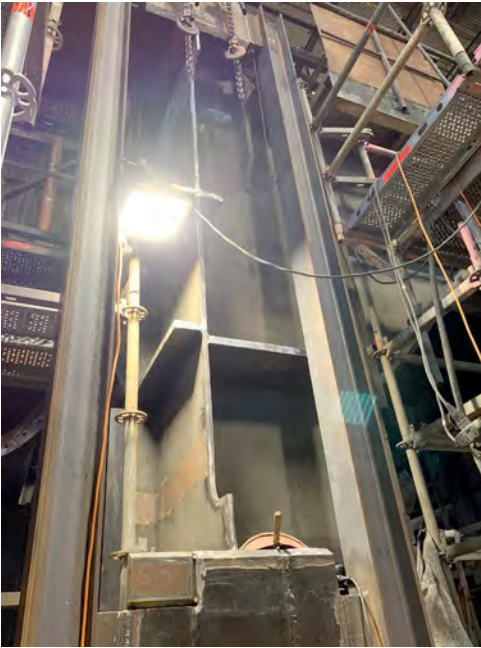
Bild 6: Sonderkonsolen – Stützenverstärkung und Aussparung für neues Einbauteil
