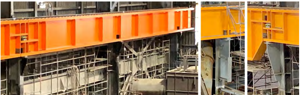
Bild 14: Konsolen nach der Montage; links: Regelkonsolen, Mitte Sonderkonsole mit und rechts ohne Kragarm
