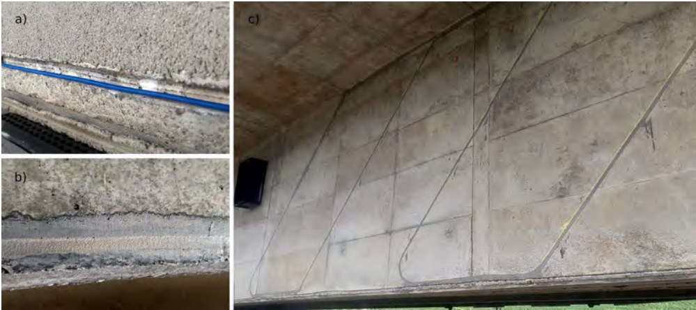
Bild 3: a) Oberflächennahe Verlegung der Sensorfaser in einer Nut, b) Installation der Messfaser nach der Verklebung, c) Ansicht der schleifenförmigen Sensorverlegung während der Installation
