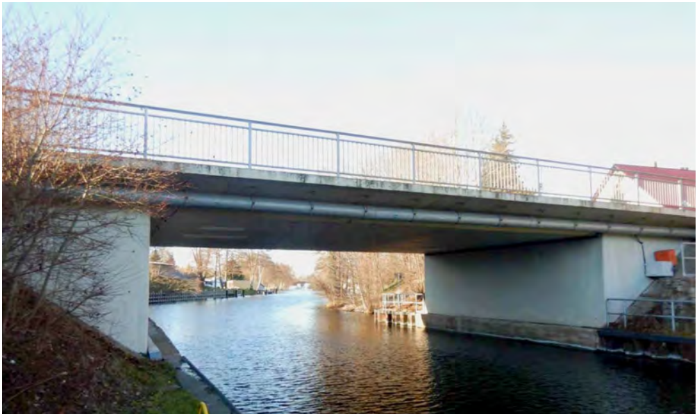
Bild 5: Brücke über die Havel im Zuge der B96 in Fürstenberg/Havel
