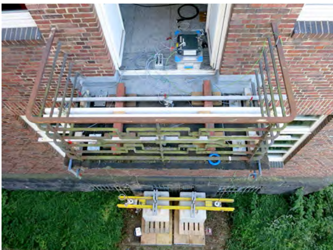
Bild 6: Denkmalgeschützter Balkon mit unbekanntem Lastabtrag (Bewehrung)
