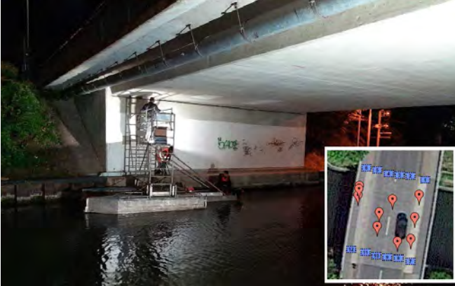
Bild 6: Installation des Monitoringsystems und Lokalisierung von Spanndrahtbrüchen (Detail rechts unten)
