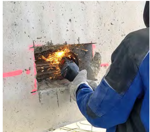
Bild 6: Durchtrennung der Spannglieder mittels Trennschleifer an Sägeschnitten
