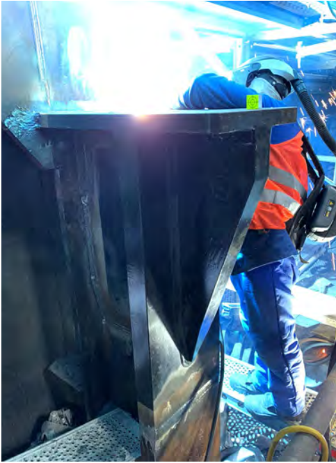
Bild 8: Montage Regelkonsole
