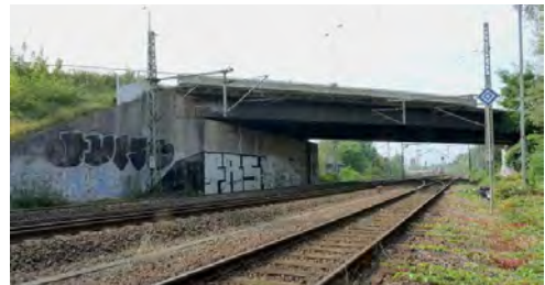
Bild 3: Brücke über die Gleise der DB im Zuge der B 1 in Brandenburg an der Havel
