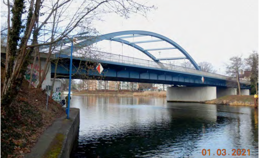
Bild 7: Brücke über die Spree im Zuge der L 35 in Fürstenwalde/Spree
