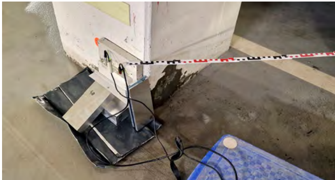
Bild 13: Versuchsaufbau für die Durchstrahlung von Stützecken für den Zustandsnachweis des Eckeisens (Horizontalschnitt) und Prüfaufbau vor Ort
