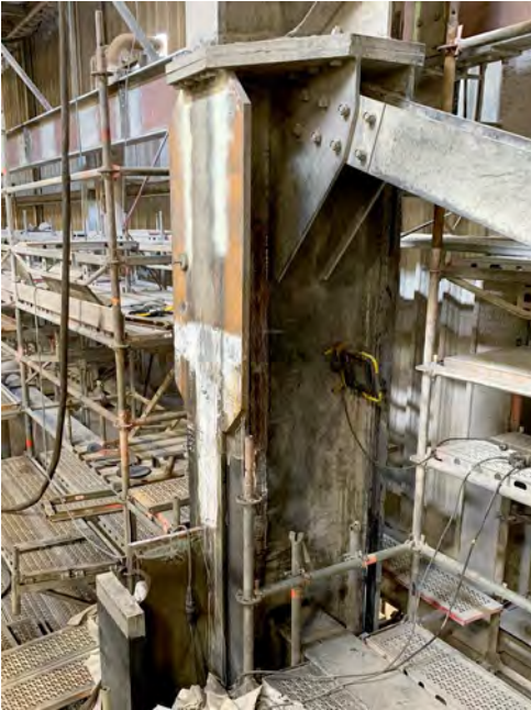
Bild 10: Regelkonsolen – Aussparung im Stützenkopf für neues Einbauteil
