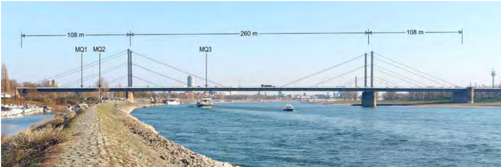
Bild 1: Ansicht der Strombrücke der Theodor-Heuss-Brücke mit Markierung der Messquerschnitte (MQ1-3)
