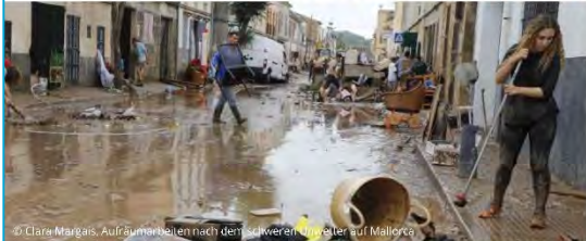
© Clara Margais, Aufräumarbeiten nach dem Aufwerden einer Straße auf Mallorca
