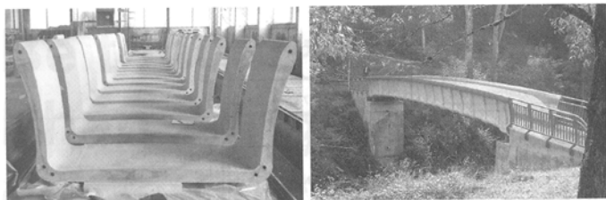
Hình 7. Cầu lắp ghép cho người đi bộ bằng bê tông lưới sợi, trước sau khi thi công [3, 26]
