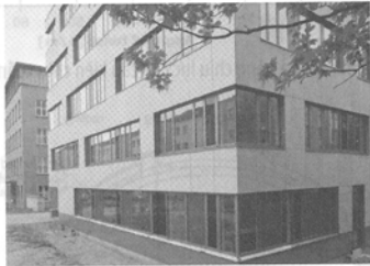
Hình 9. Panel bằng bê tông lưới sợi trong khuôn viên trường đại học TU Dresden [3]
