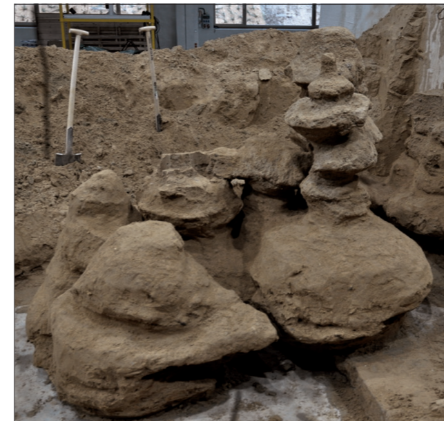
Bild 2: Injektionsergebnis mit Ausbauchung im unteren Bereich und keinem Verbund in oberflächennahen Schichten (GR2)
