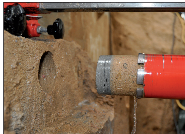
Bild 12: Probenentnahme mittels Kernbohrung, Kontaktzone Beton – Injektionskörper
